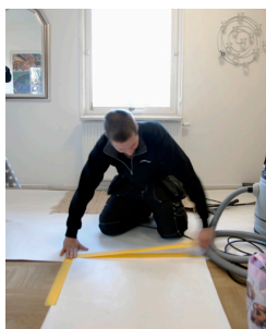
Förbered noga med skyddspapp.
