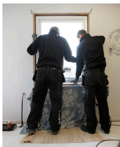
Nya fönstret sätts på plats.
