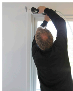
För att slippa måla om sätts lite bredare foder upp.
