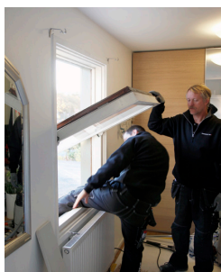
Ta bort den gamla fönsterbågen.
