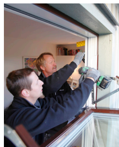
Fönstret justeras in med karmhylsor och skruvas fast.
