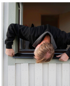
Montering av nytt fönsterbleck.
