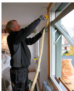
Ny isolering mellan karm och vägg.
