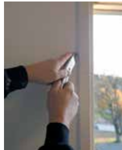
Skär loss tapet från invändiga foder.
