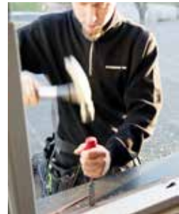
Lossa gammalt foder på utsidan.
