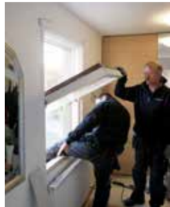
Ta bort den gamla fönsterbågen.
