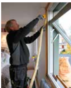
Ny isolering mellan karm och vägg.
