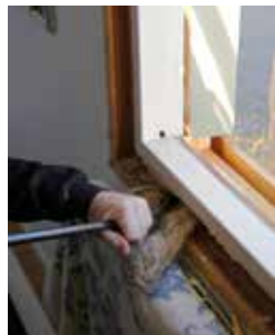
Gammal drevning petas fram och slängs.
