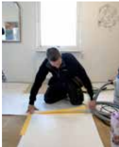
Förbered noga med skyddspapp.
