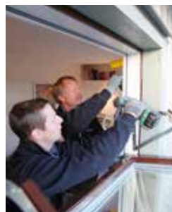
Förmonterad karmskruv följer karmen.
