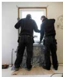
Nya fönstret sätt på plats.
