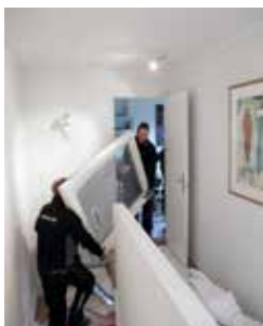
Dags att hämta det nya fönstret.
